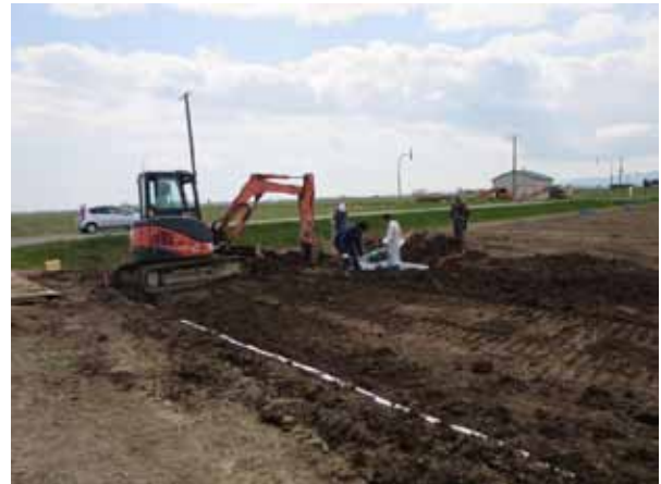
【参考 断熱材（発泡スチロール）の埋設工事状況】
