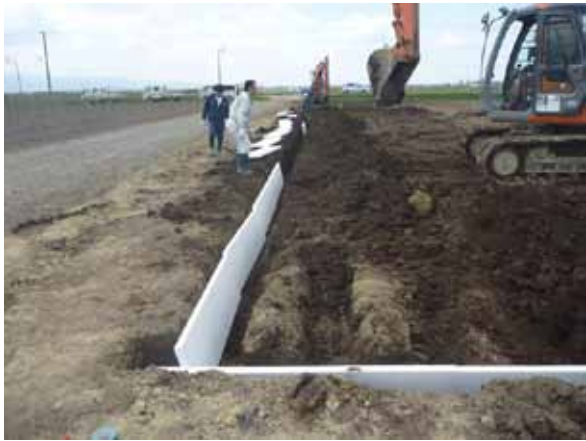
【参考 断熱材（発泡スチロール）の埋設工事状況】
